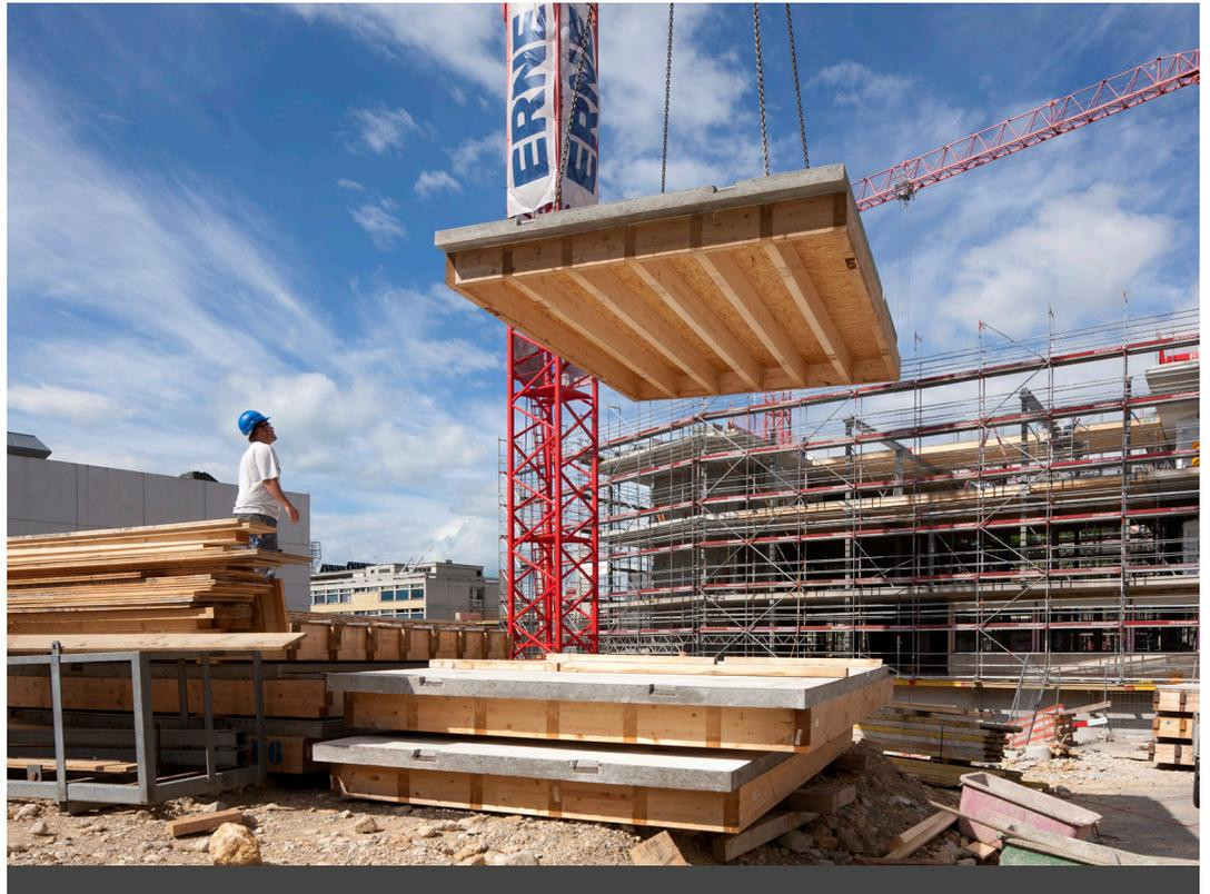
Montage sur le chantier des éléments de dalles préfabriqués en bois-béton. © Y. André
