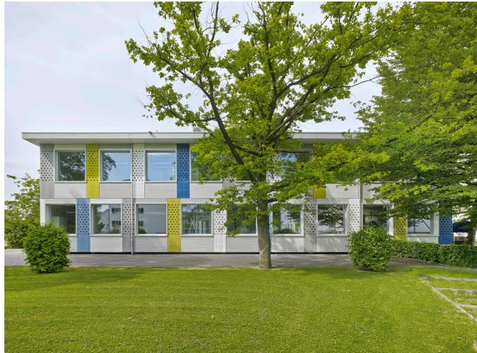
La famille modulaire trouve son origine en 1986 dans le projet pour une maison jumelée à Mühlethurnen BE. Il anticipe (jusqu'à la mobilité) ses points clés ultérieurs: une construction légère en bois, une structuration systématique sur une trame, des connexions sans orientation et une construction visible.
