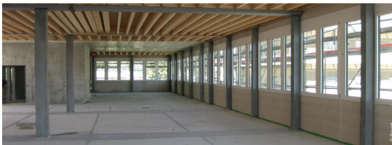
L'alliage bois-béton mis en place à Microcity.
